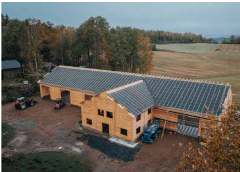
Massivtre: Den nye låven på Tallaksrud gård bygges i helnorsk massivtre. / FOTO: Jonas Ruud
