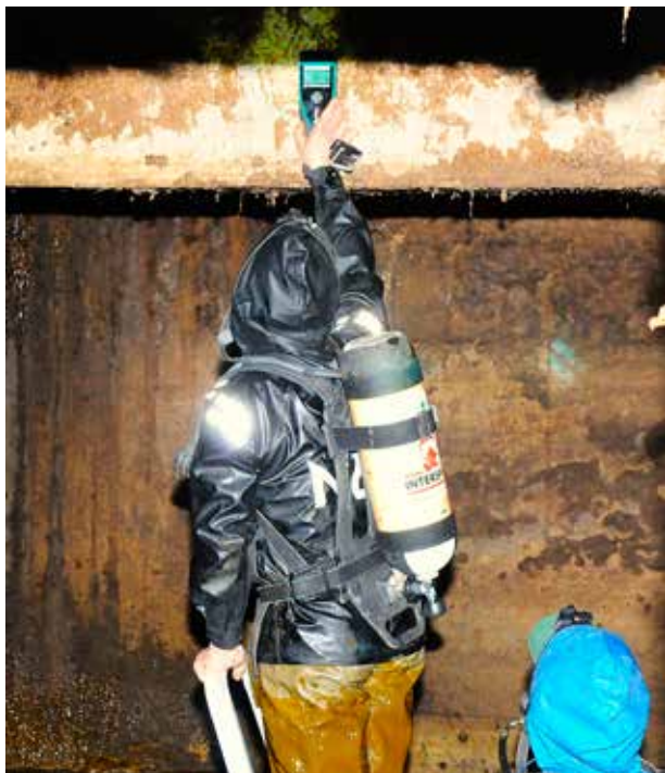
Sjekk: Ola i ferd med å kartlegge armeringa med armeringsdetektor. / FOTO: Bjørn Steinar Skarbø
