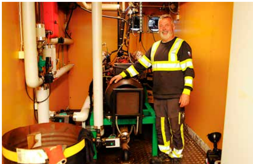
V6: Gaute Måøy med generatoren som vert driven av ein V6 Chevrolet-motor modifisert for gassdrift. / FOTO: Bjørn Steinar Skarbø
