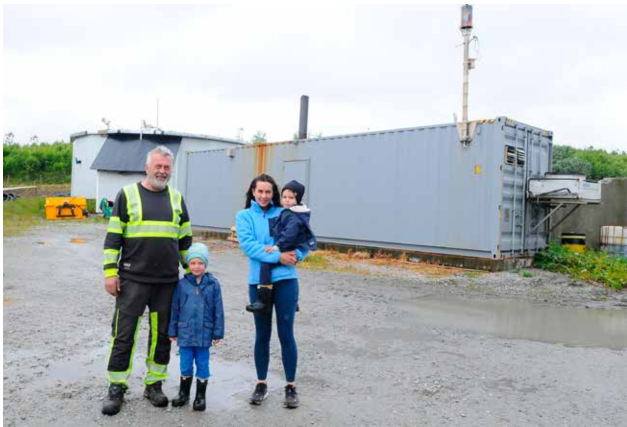
Biogass: Gaute Måløy saman med dottera Guro og hennar born Hermann og Ragnar (på armen) framom biogass-anlegget med reaktoren (bakerst) og teknikk-konteineren. / FOTO: Bjørn Steinar Skarbø
