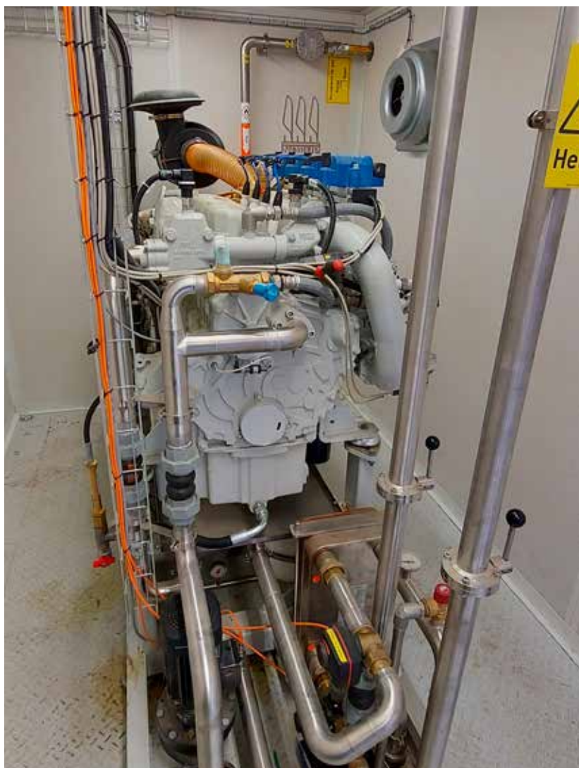
Motor: Et eksempel på gassmotor i et gårdsanlegg
