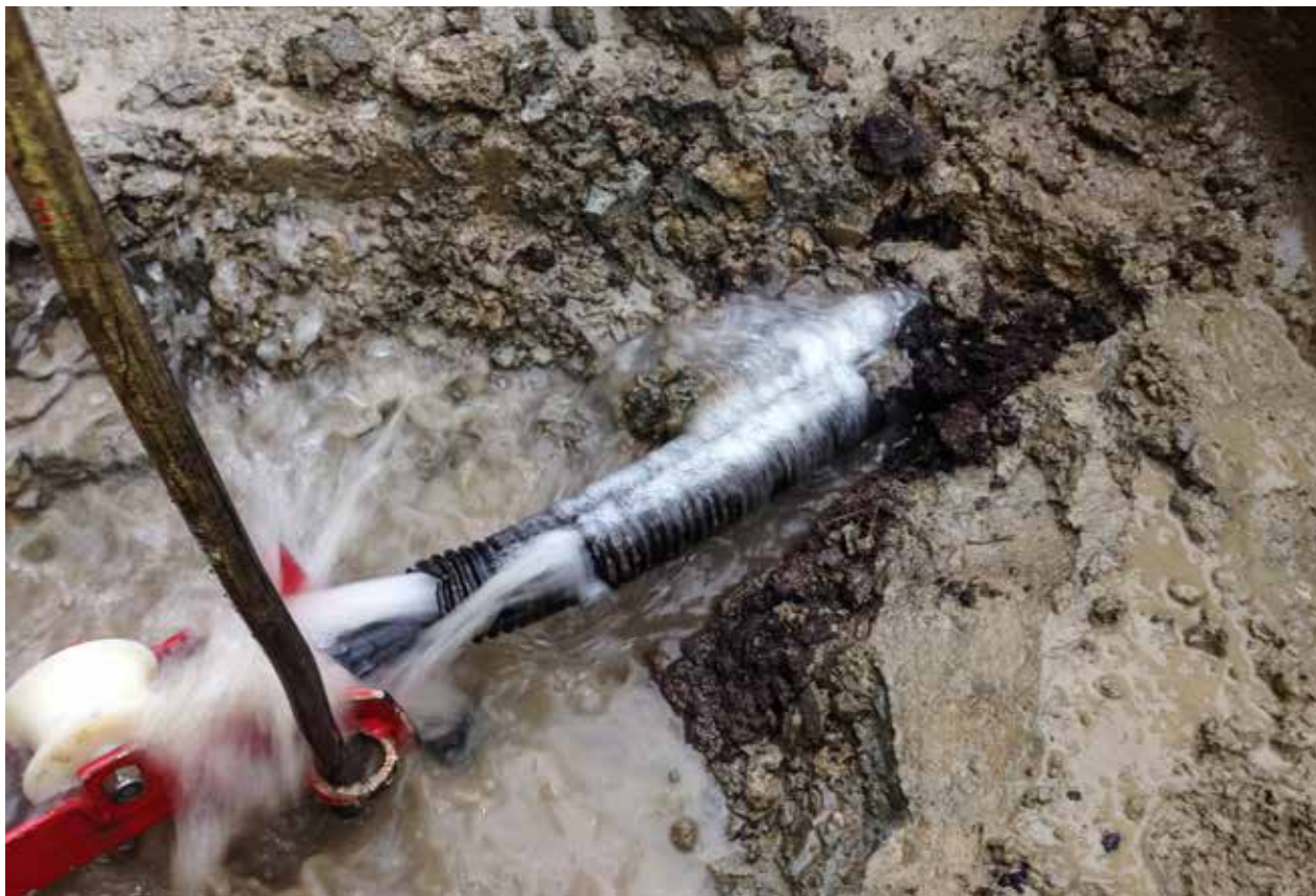
Vedlikehold: Dreneringssystema treng vedlikehald for å gjere ein god jobb. Spyling av røyr kan vere ei av fleire oppgåver. / FOTO: Åsmund Langeland
