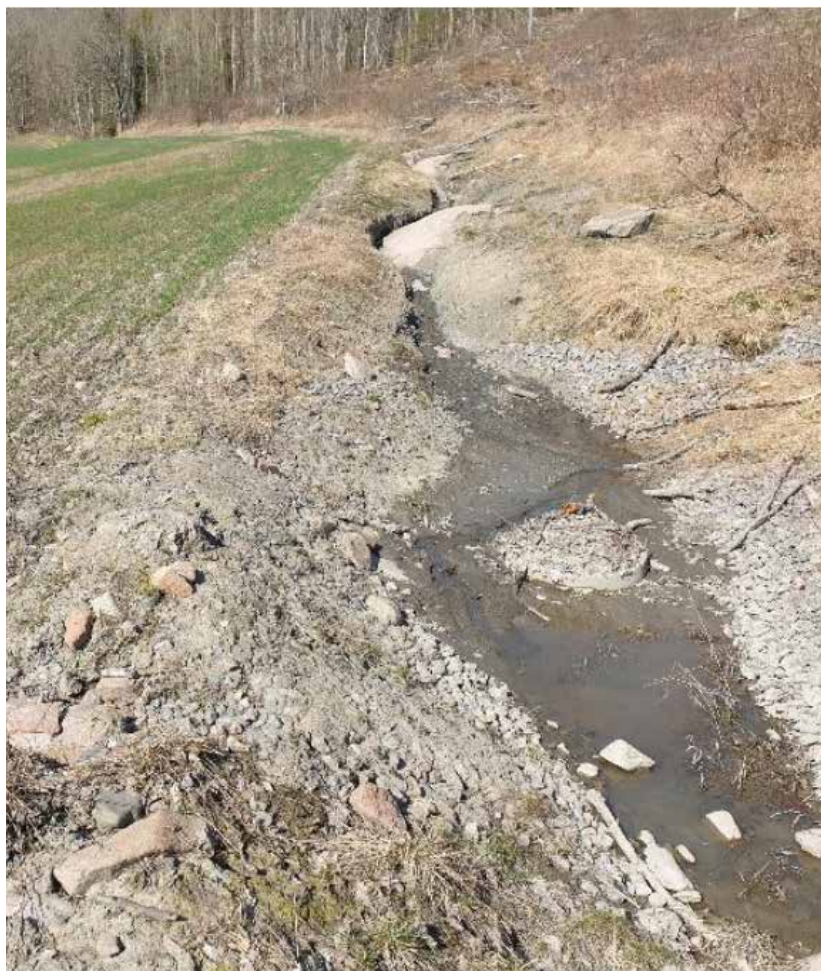
Avskjæring: Avskjæringsgrøfter med god dybde og slakke sidehelninger, med åpne og riktig dimensjonert rørlukkinger er viktige for å unngå bløte partier på jordet og at vannet renner over og eroderer på dyrka mark.
