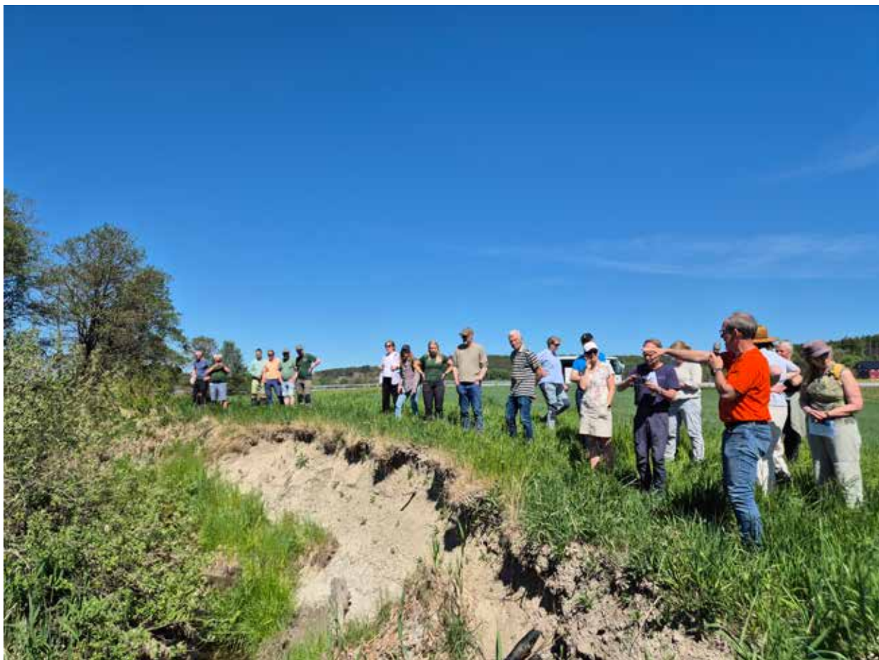
Befaring i bekkekant: Øyvind Akselsen, rådgiver i NLR, under ei befaring på markdagen til SABICAS-prosjektet. Han kommer med forslag til tiltak om steinsetting rundt grøfteutløp i tillegg til å bruke stive, tette rør ut i bekken.
