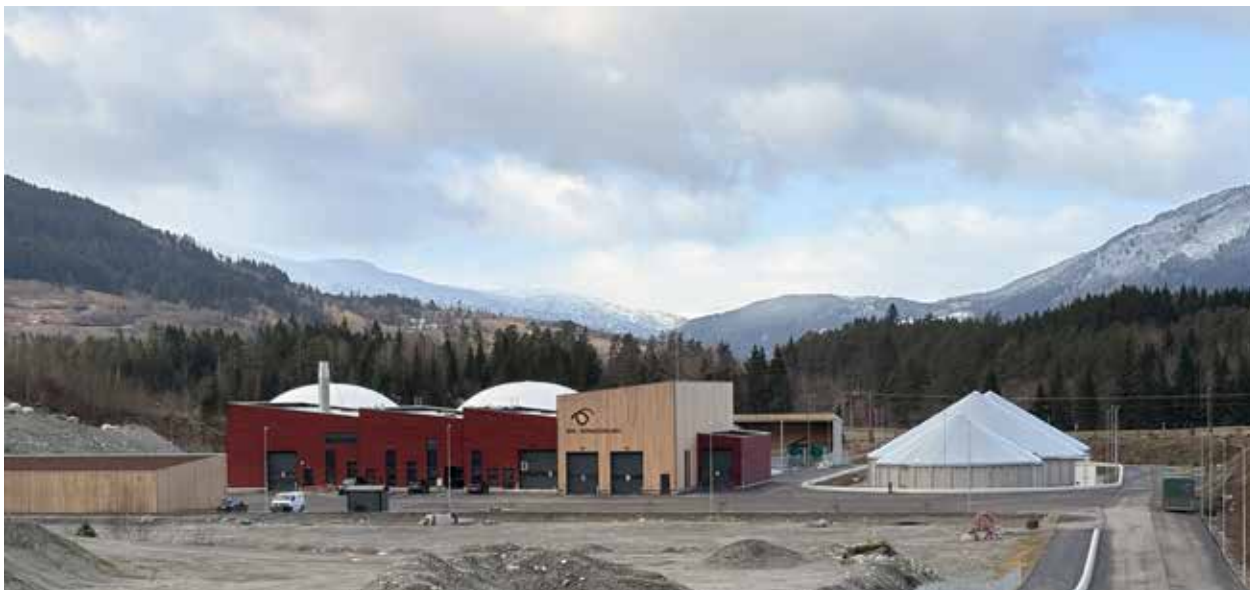
Grønn energi: Det nye biogassanlegget på Voss er et nullutslippsanlegg for grønn energi.
