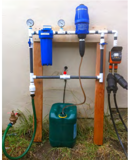
Døme på ein liten Dosatron som er lagt opp til å vatna to felt
