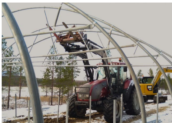
Bilde 4. t.v Nedsetting av forankringsrør for tunnelbuene. Rørene kan trykkes ned med gravemaskin hvis det er steinfri mark. t.h Buene løftes på plass parallelt med at bordstolpene. Foto: Kristin Sørensen, NLR
