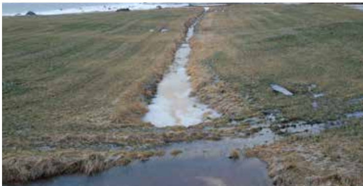
Eksempel på for bredt profil i fht. tilgang på masser. FOTO: Are Johansen
