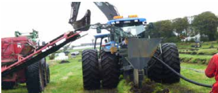
Legging av dreneringslange og filter.
