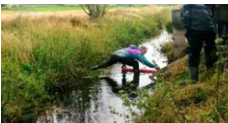
Sikring av grøfteutløp.
