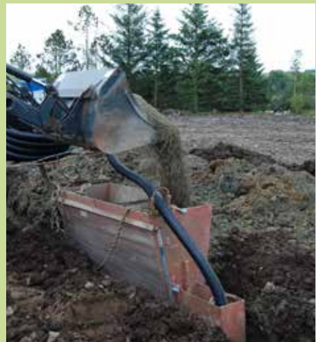
Påfyll av filter.
