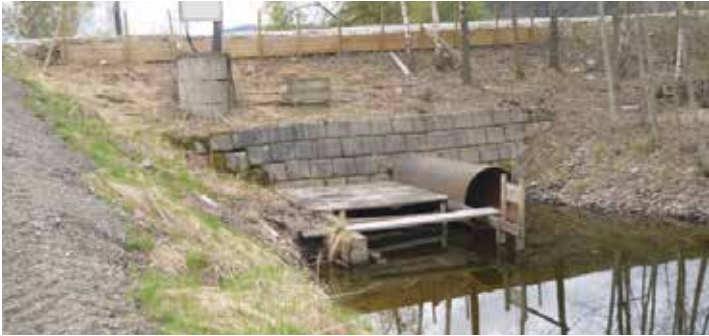
Pumpestasjon i enden av kanal.
