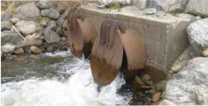
Klaffluke slepp vatn ut gjennom forbygging.
