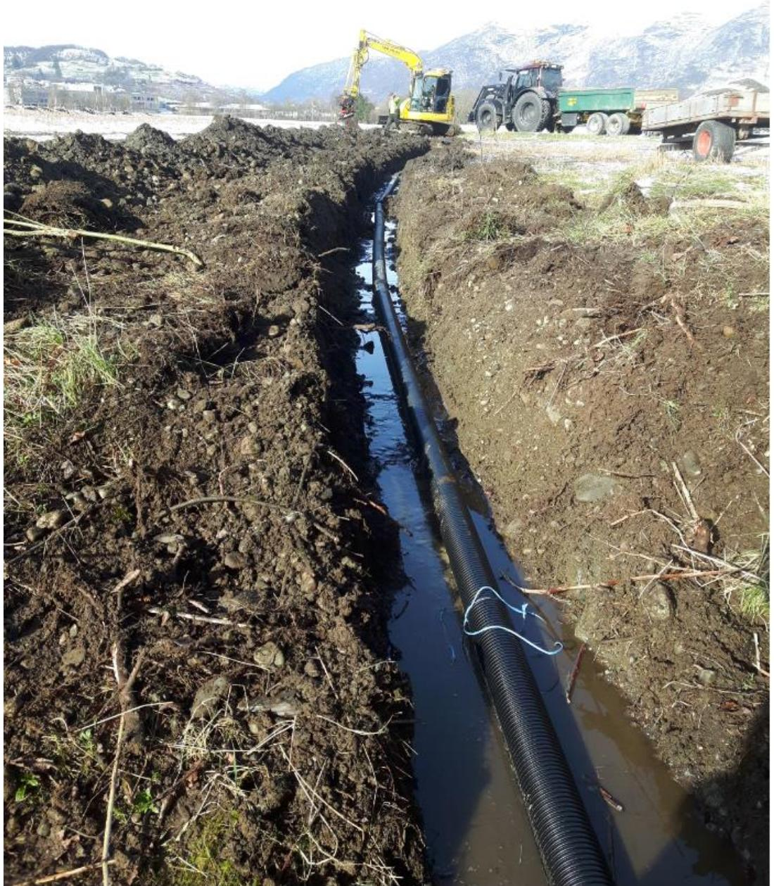
Grøfting av vått parti i eng med DV 110 dreneringsrør. For å betra infiltrasjon av overflatevann, vart det brukt singel 2-8 som grusfilter. Etne 4. april 2020.
