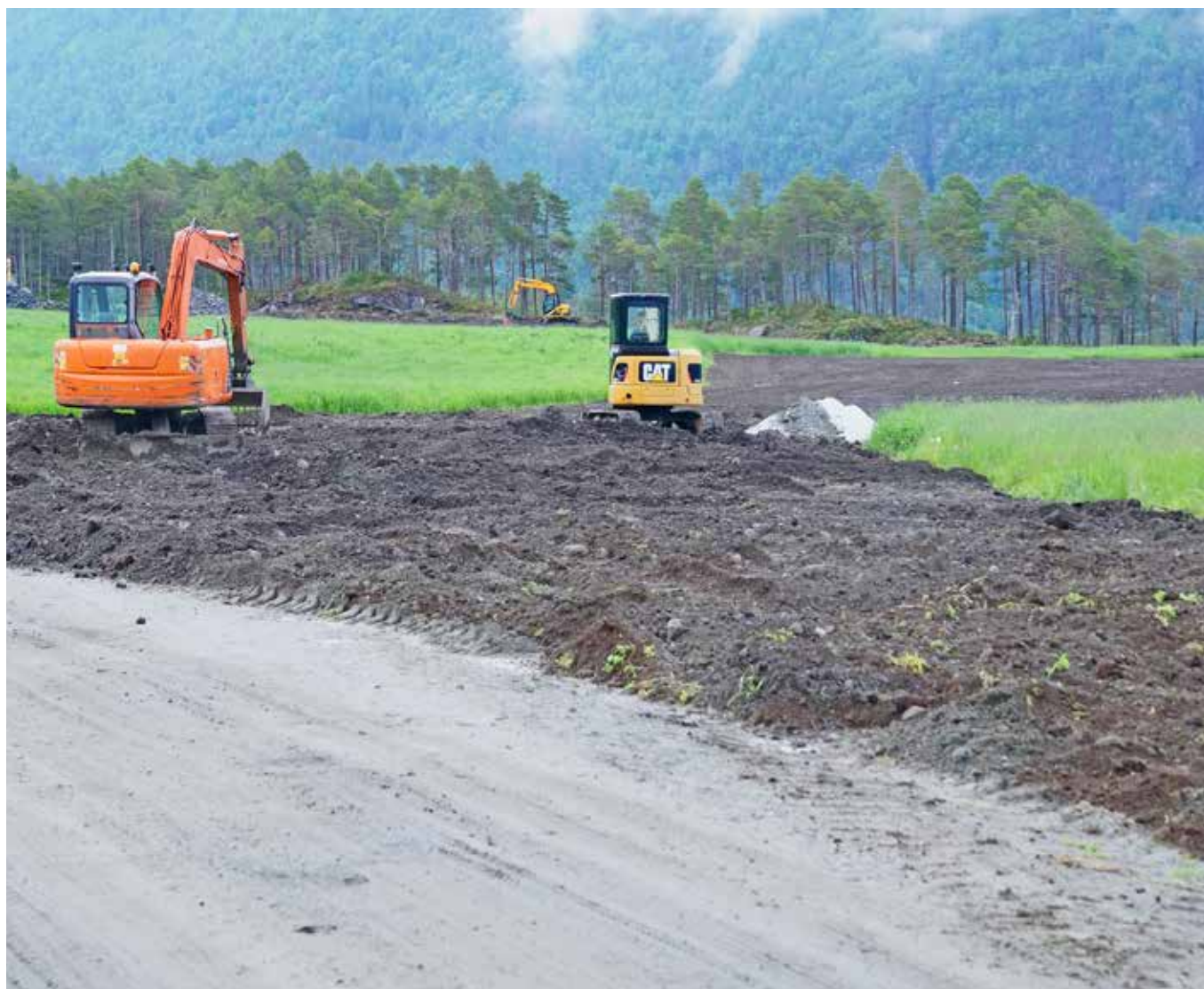
Siste del av arbeidet, med utlegging av A-sjikt eller matjordlaget. Små lette maskinar minskar risikoen for skadeleg og langvarig pakkeskade.
