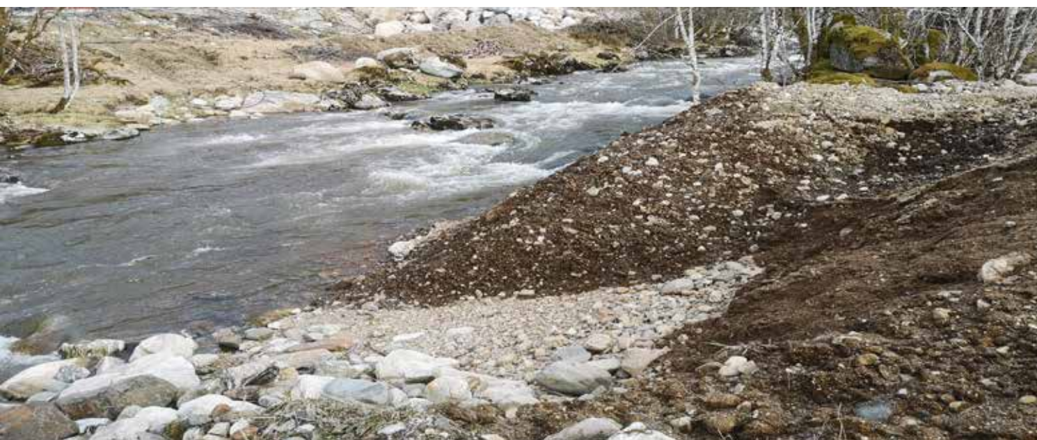
Uheldig plassering av jordmasser nær vassdrag
