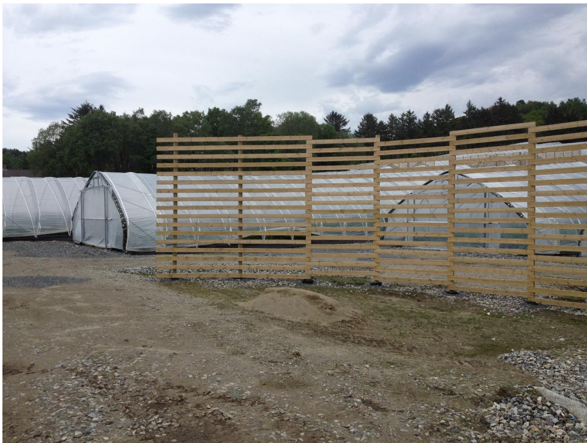
Figur 2. Levegg av stolpar og lekter. Foto: Stanislav Strbac, NLR Viken
