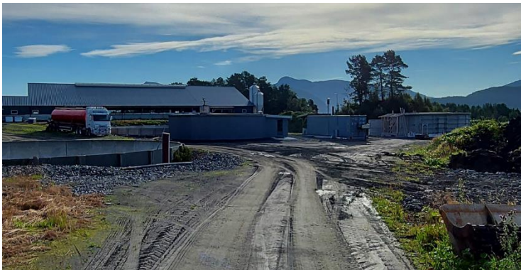
Gårdsbiogass Hoemsnes, bilde Dohrn, NLR
