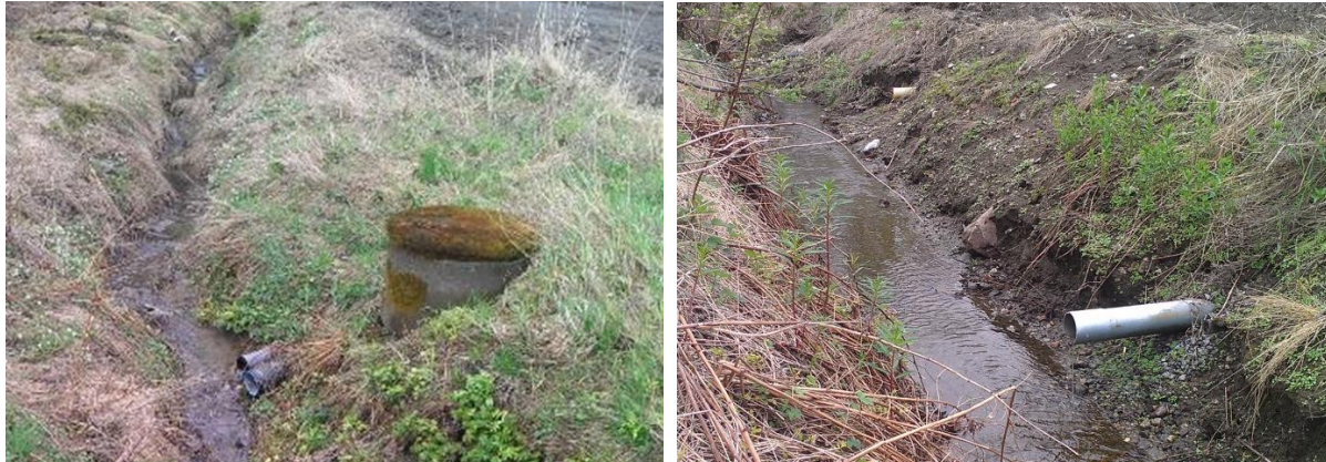
Kanalsider med liten helningsgrad og utløpsrør over kanalbunnen.
