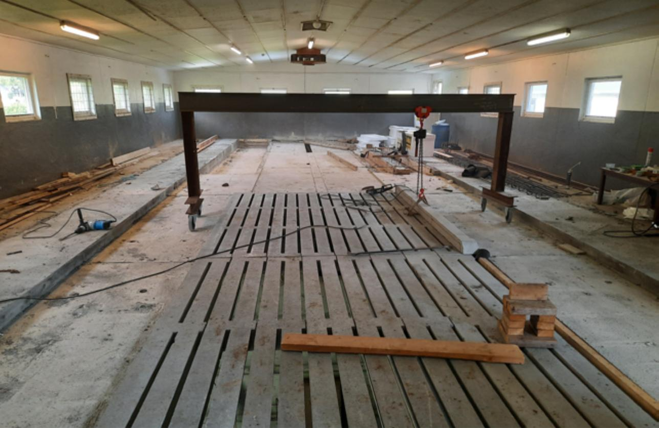
*Sjølvgjort er velgjort: Mads Håvard er sveisar av yrke og laga denne hjulgåande traversen sjølv. Den var veldig nyttig i arbeidet med å fjerne betongelement og legge inn betongspalt.*
