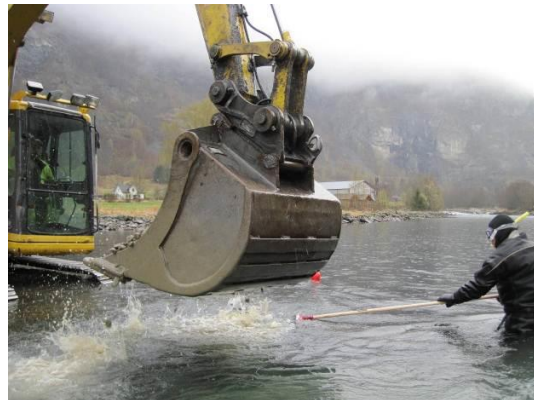
Figur 4 Dykker har utvalgt et egnet sted for grusutlegget og anviser gravemaskinføreren
